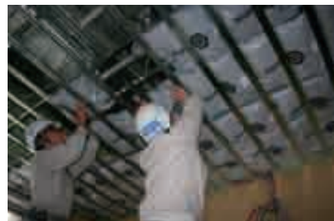
新病棟病室天井への敷設作業
